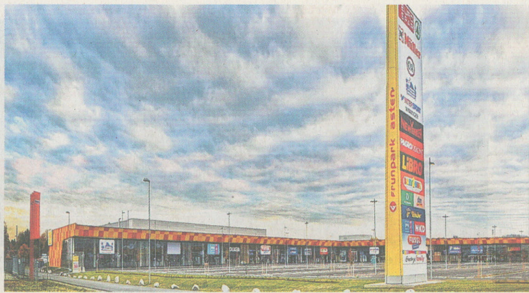
Der Frunpark Asten besticht durch überzeugende Vorteile: Die u-förmige Anordnung der 26 Shops
